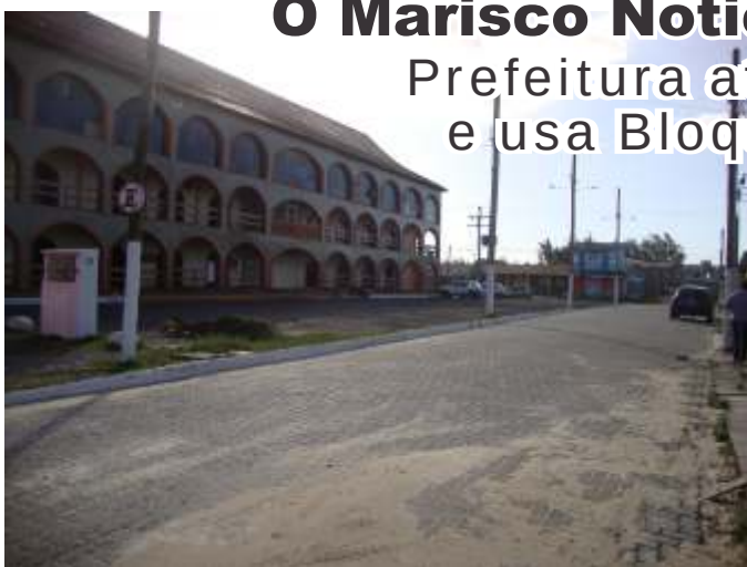
Rua pavimentada com bloquetes de cimento em Cidreira
